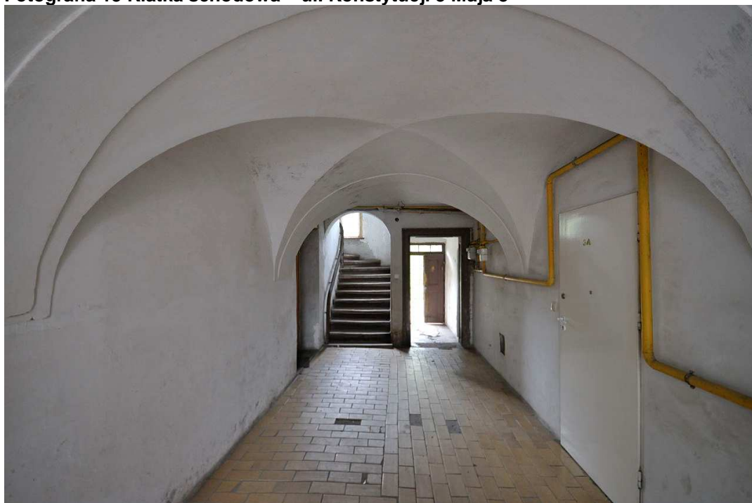
Fotografia 13 Klatka schodowa – ul. Konstytucji 3 Maja 8
