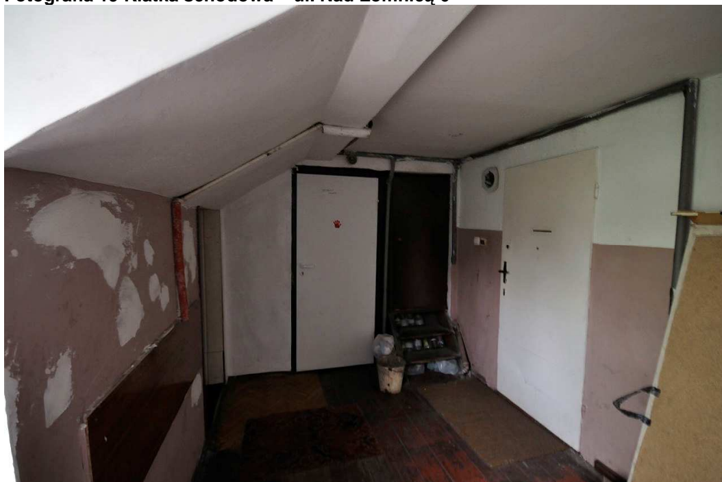
Fotografia 19 Klatka schodowa – ul. Nad Łomnicą 6
