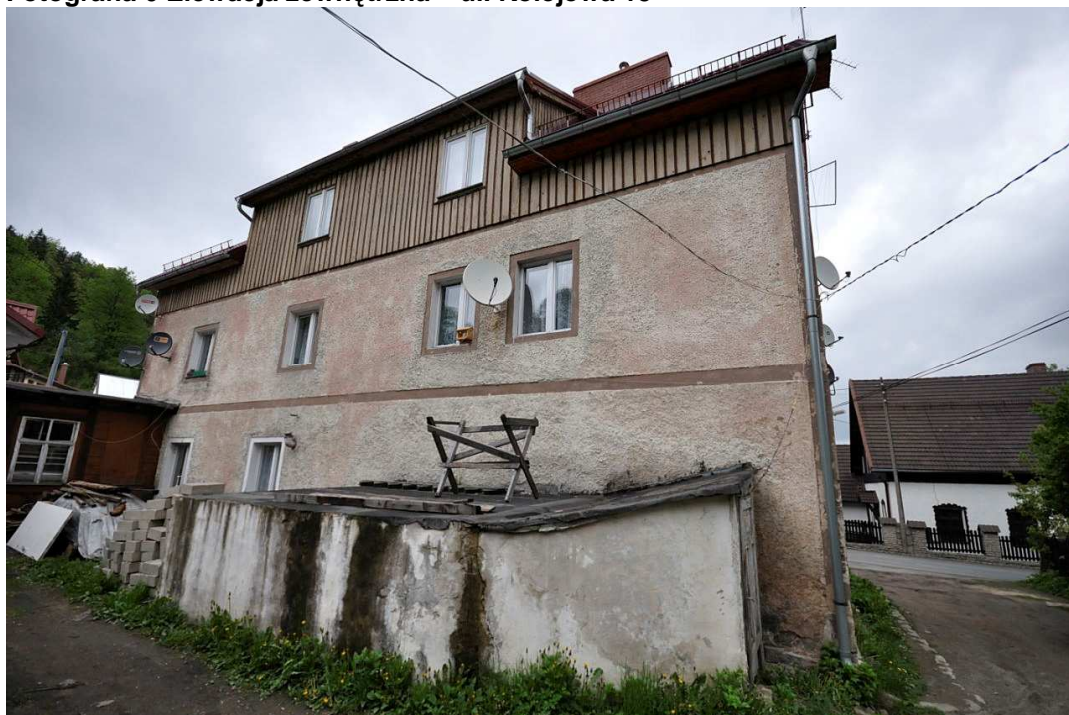
Fotografia 6 Elewacja zewnętrzna – ul. Kolejowa 15
