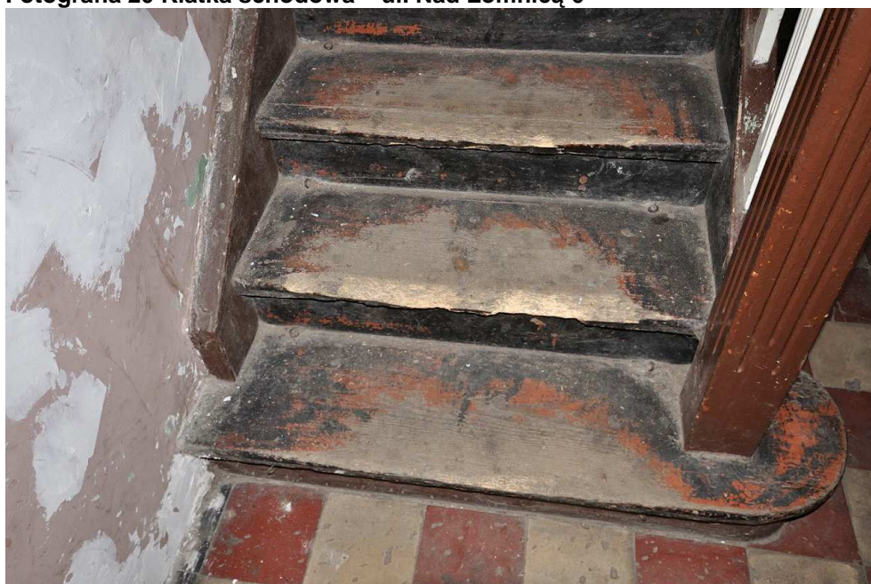
Fotografia 20 Klatka schodowa – ul. Nad Łomnicą 6
