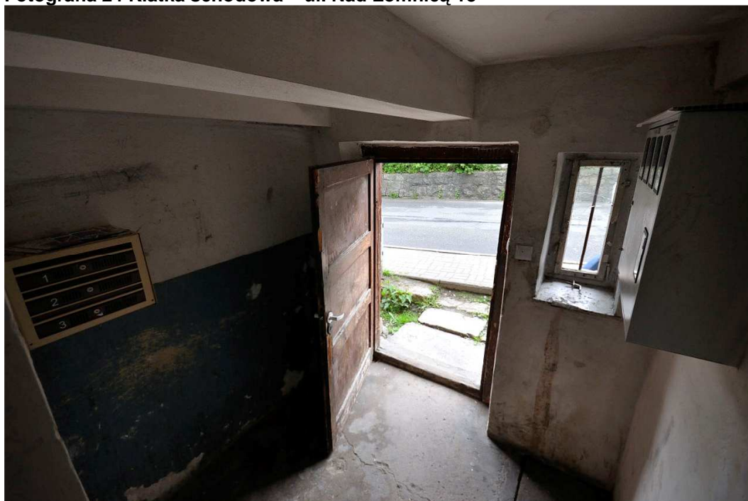
Fotografia 24 Klatka schodowa – ul. Nad Łomnicą 18
