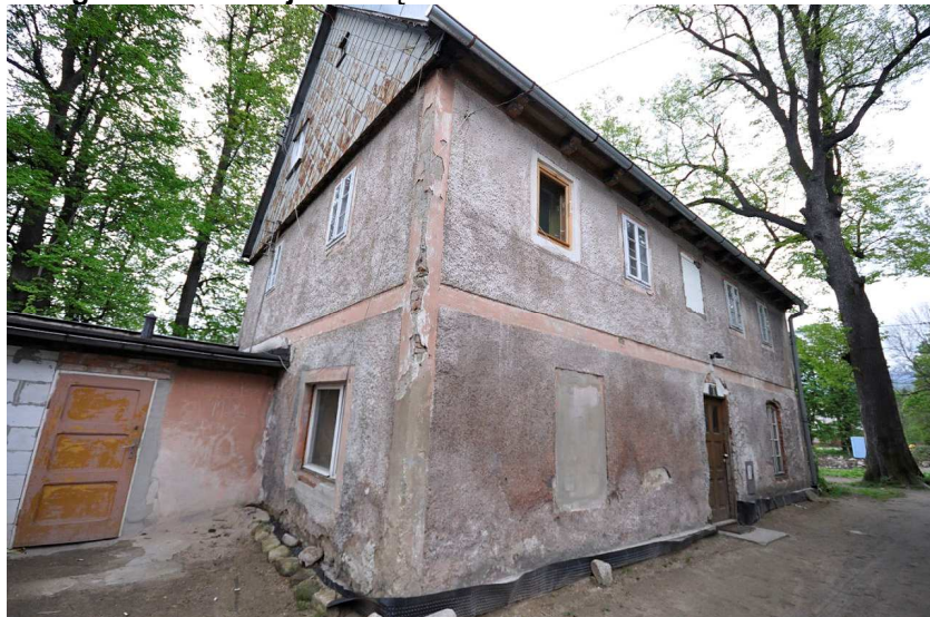
Fotografia 2 Elewacja zewnętrzna – ul. Boczna 1
