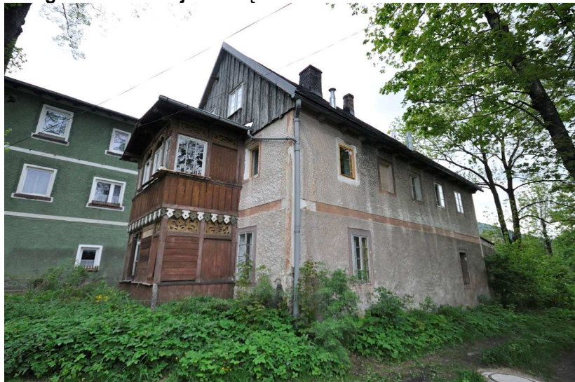
Fotografia 5 Elewacja zewnętrzna – ul. Boczna 1
