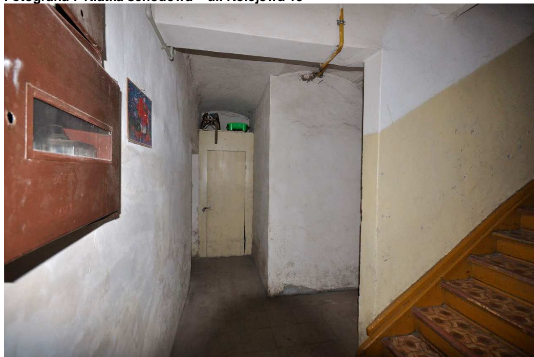
Fotografia 7 Klatka schodowa – ul. Kolejowa 15
