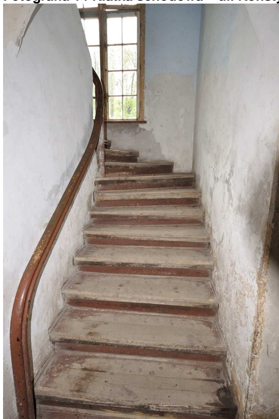
Fotografia 14 Klatka schodowa – ul. Konstytucji 3 Maja 8
