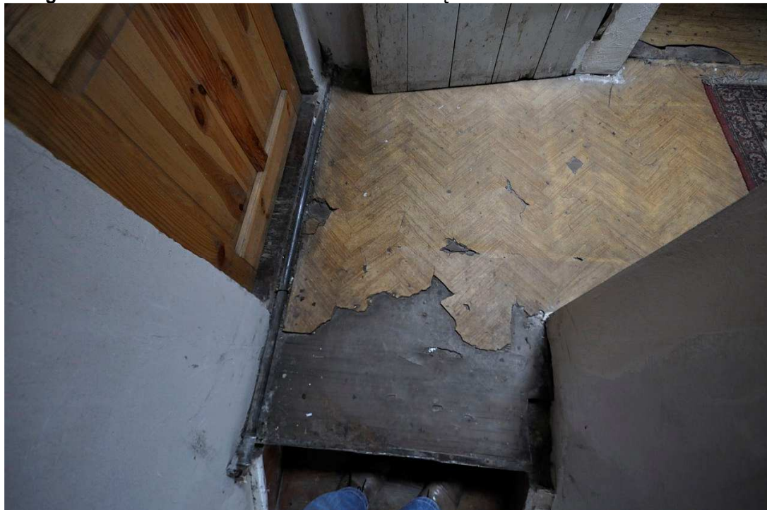
Fotografia 25 Klatka schodowa – ul. Nad Łomnicą 18
