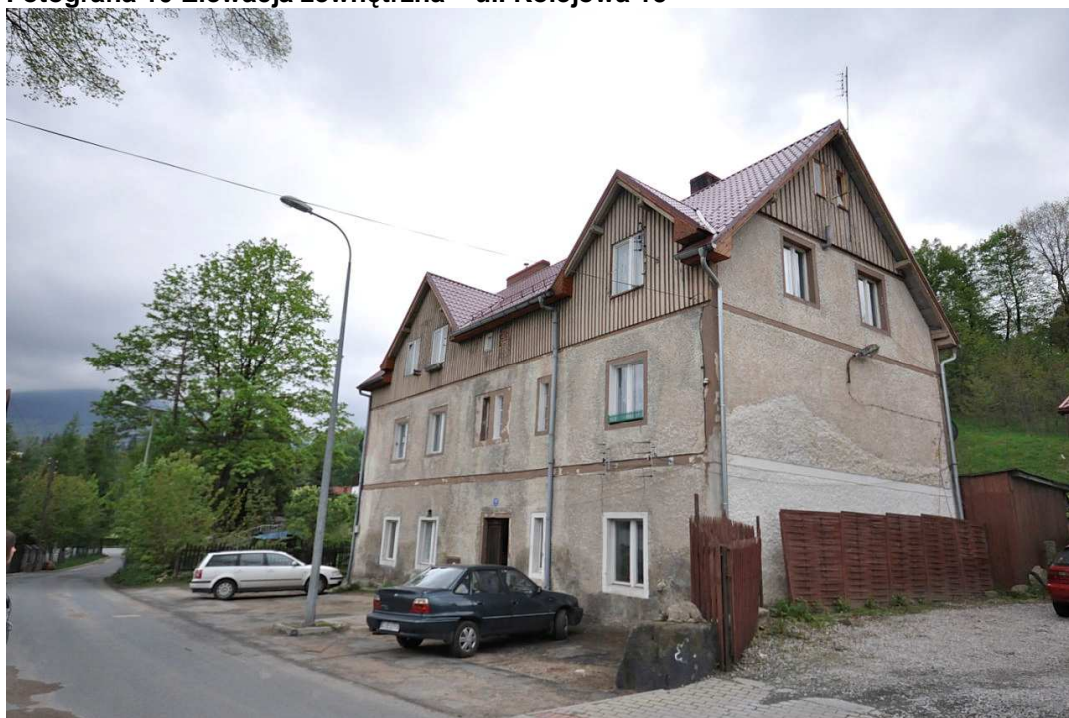
Fotografia 10 Elewacja zewnętrzna – ul. Kolejowa 15
