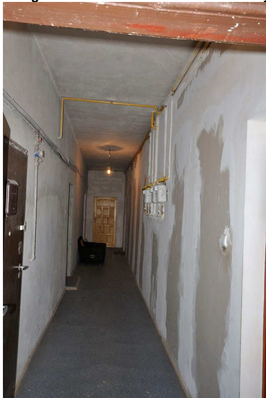
Fotografia 15 Klatka schodowa – ul. Konstytucji 3 Maja 8
