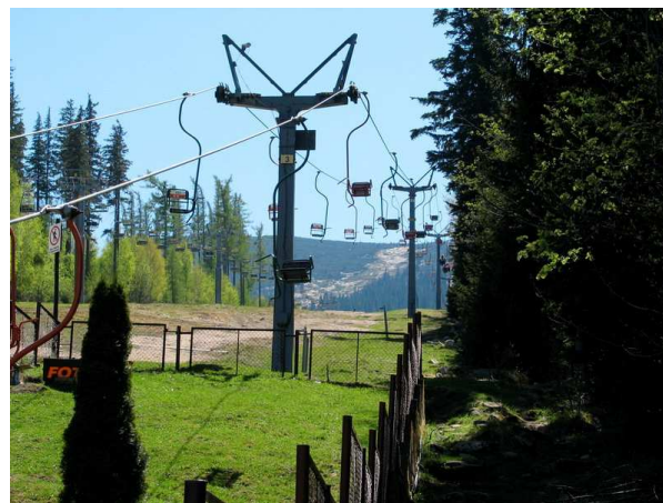
2. Dolny odcinek kolei – widok w kierunku Kopy.
