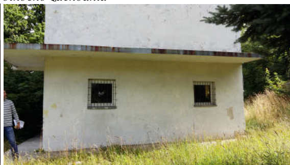
Foto 3 Elewacja południowo- zachodnia
