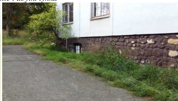
Foto 8 Widok elewacji szczytowej z piwnicą
