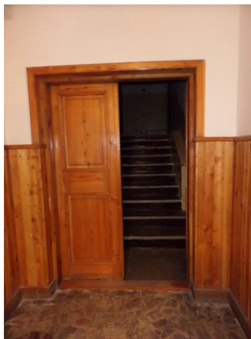
fot. Drzwi przy przejściu do toalet
