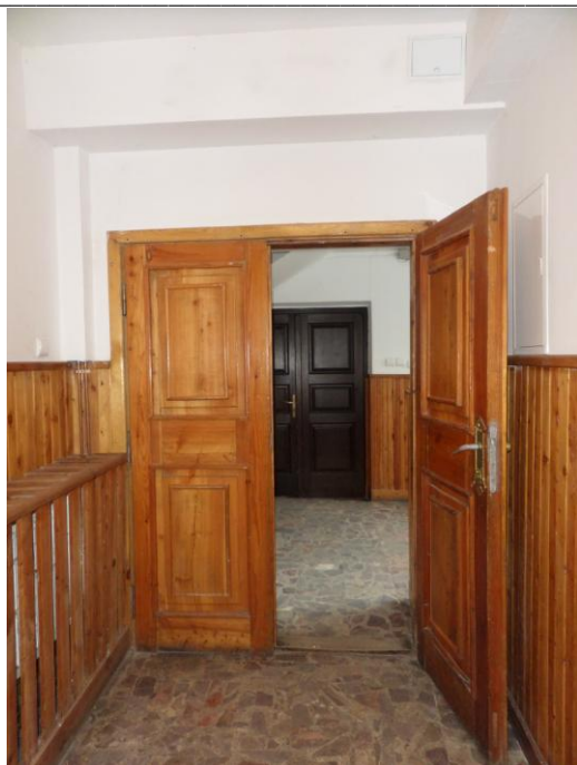
Fot. Drzwi pomiędzy korytarzem a klatką schodową
