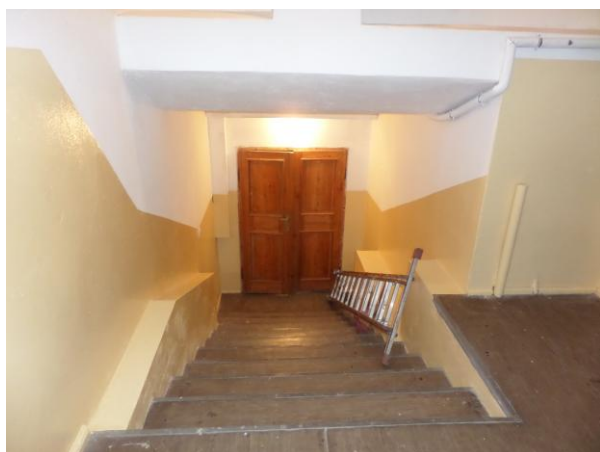
Fot. Widok schodów wewnętrznych z podestu górnego
