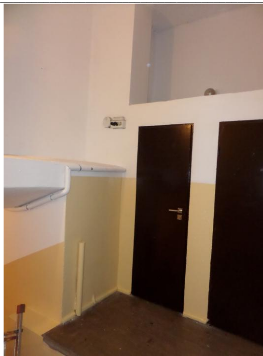
fot. Podest przed pomieszczeniami wc
