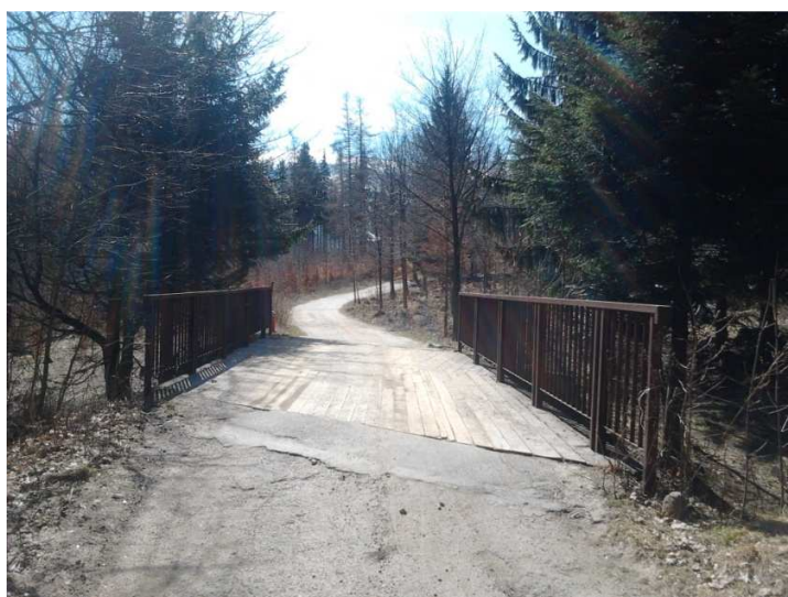
Fot. 3 Istniejący most nad dawną trasą saneczkową
