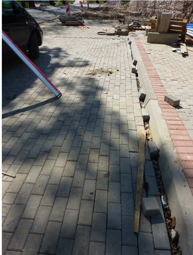
Fot.16 Nawierzchnia parkingu. Wady ułożenia kostki- brak liniowości oraz równoległości w stosunku do krawężnika
