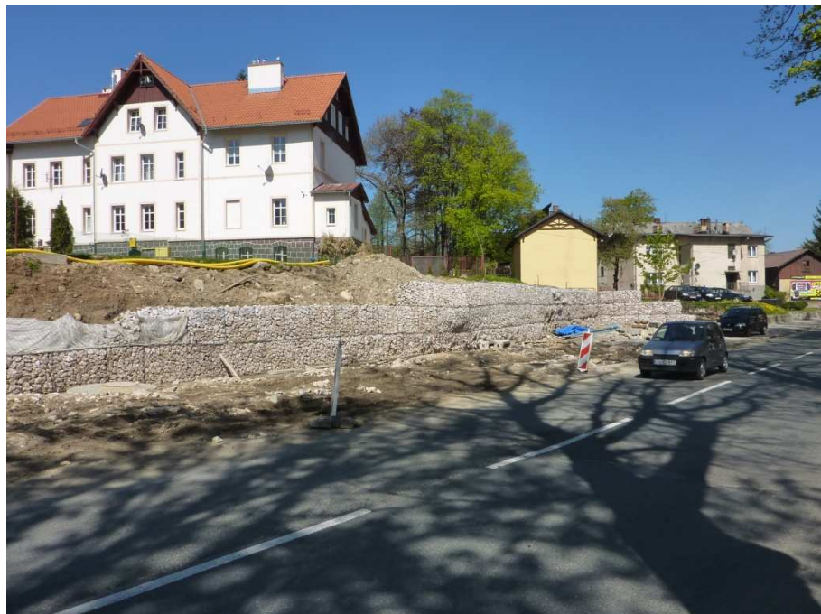
Fot.3 Wyższa część konstrukcji oporowej o wys. około 2,9 m
