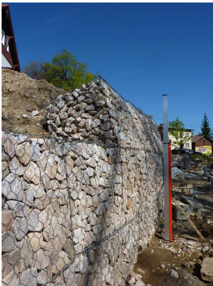
Fot.6 Pomiar odkształcenia konstrukcji w miejscu największej deformacji .
