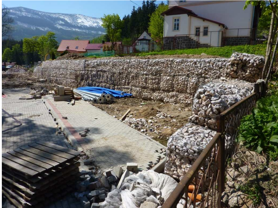
Fot.2 Ogólny widok konstrukcji oporowej z gabionów
