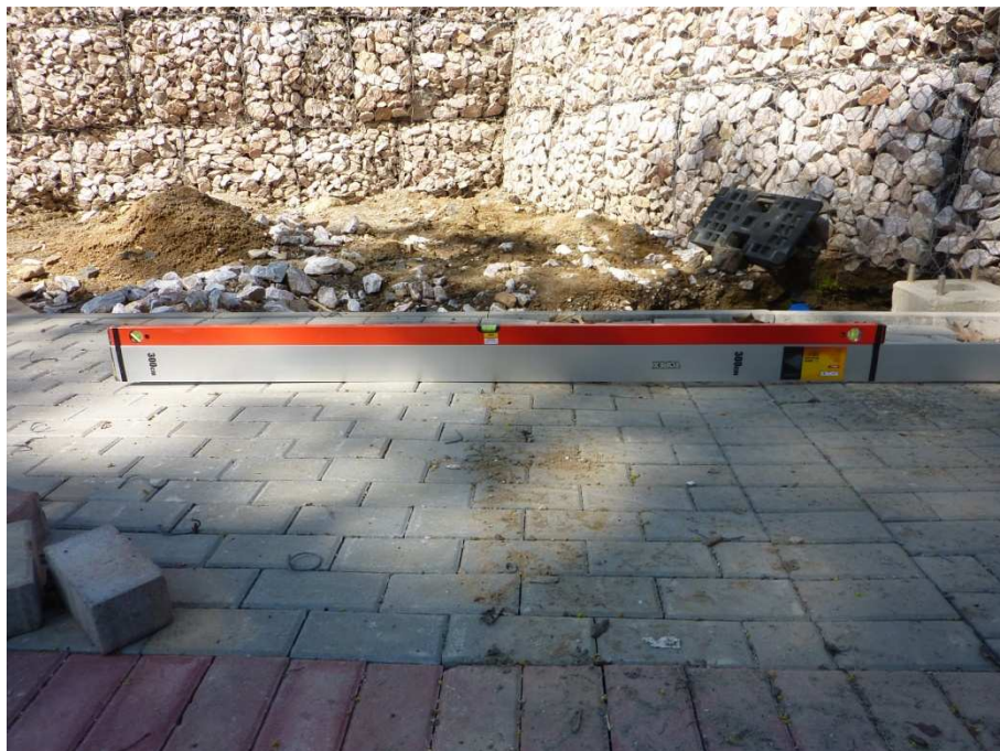
Fot.11 Pomiar równości podłużnej wykonanej nawierzchni chodnika
