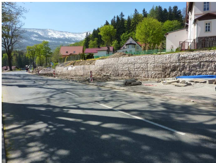
Fot.1 Widok ogólny rejonu robót przy ul. Obrońców Pokoju
