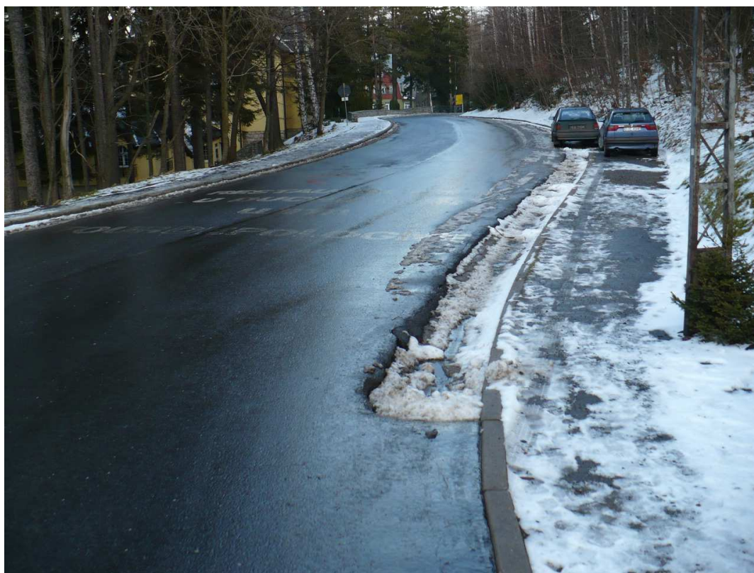
Fotografia 20 Koryta betonowe km 1+966
