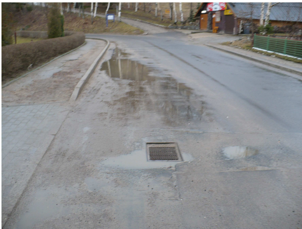
Fotografia 2 Nawierzchnia ul. Strażackiej
