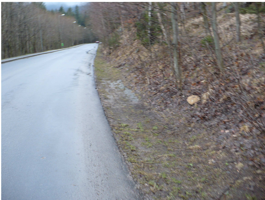
Fotografia 18 Ściek z kostki granitowej km 0+350
