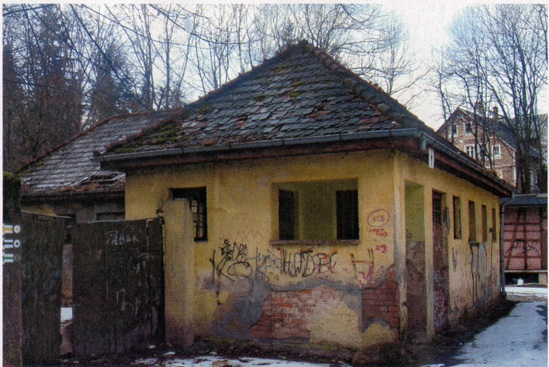
Fot. 2 – budynek toalet – widok od strony elewacji wschodniej
