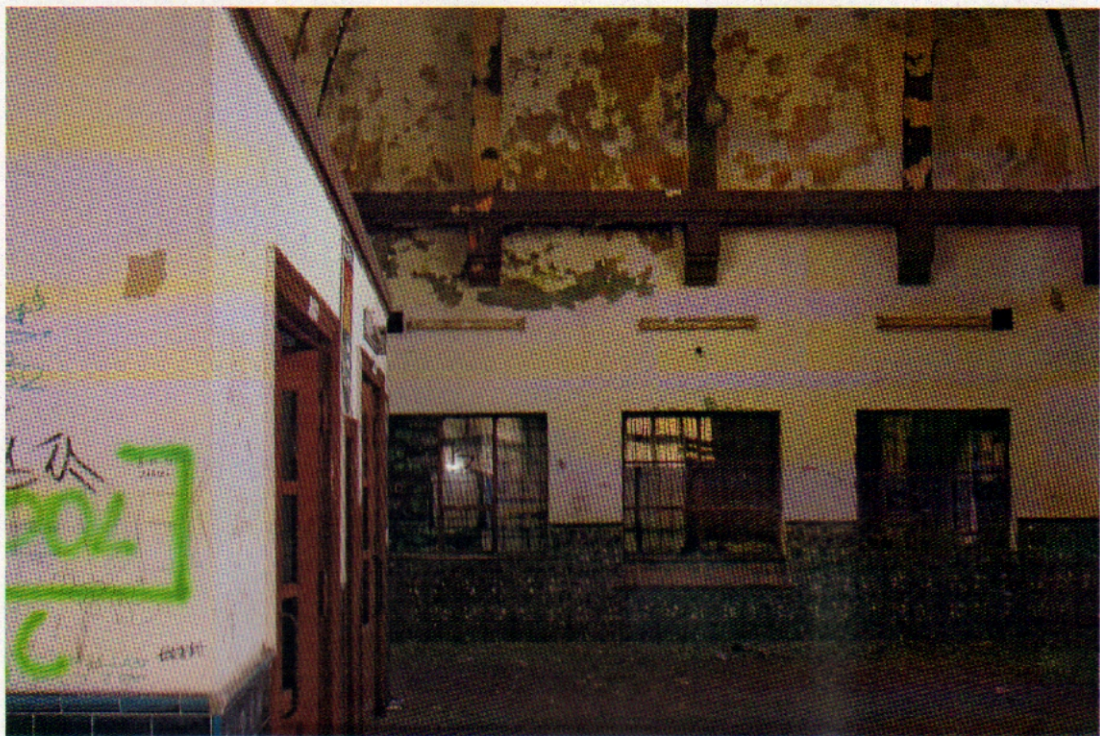
Fot. 7 widok na hol główny dworca – okienka kasowe.
