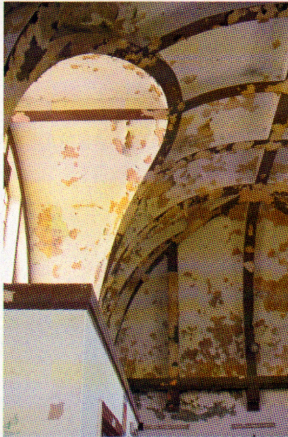
Fot. 6 Widok na kopułę żelbetową zebrowaną hali dworcowej głównej.
