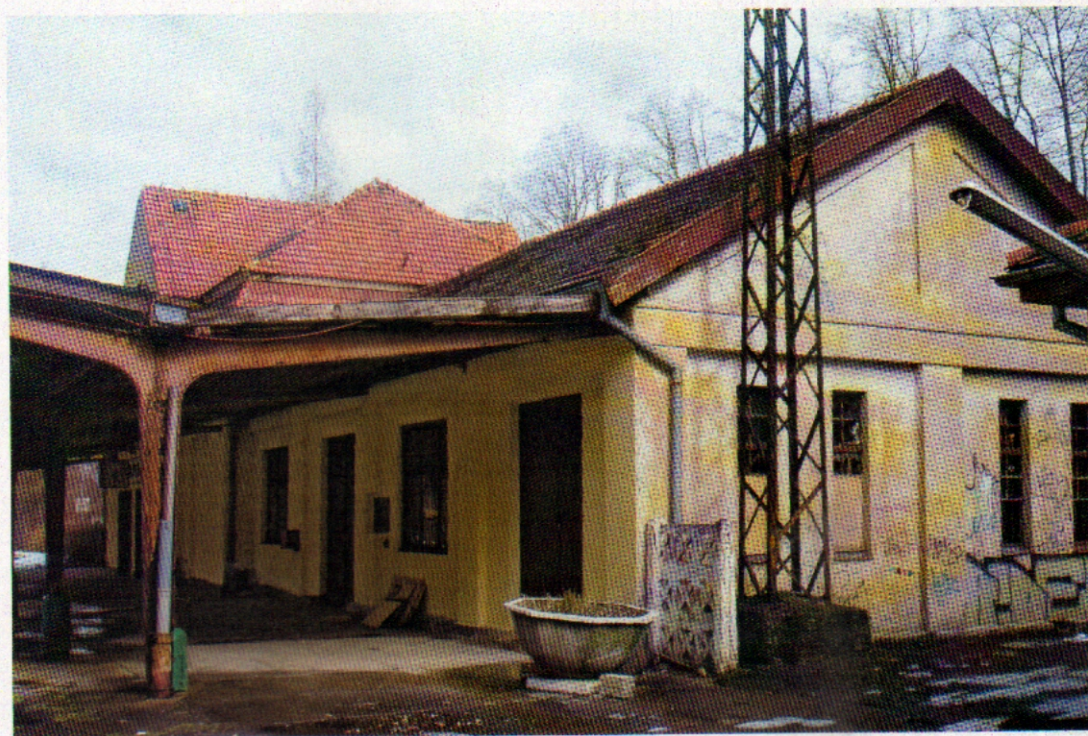
Fot. 3 – Elewacja południowa niższej części budynku dworca i wiaty peronowa.
