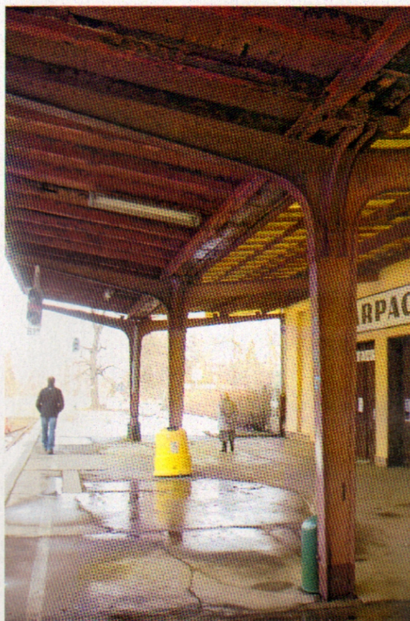
Fot. 5 – Widok na wiatę peronową i więzar blachownicowy nitowany.
