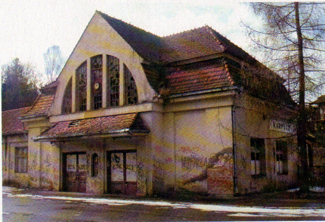
Fot. 2 – Elewacja wschodnia hali głównej dworca
