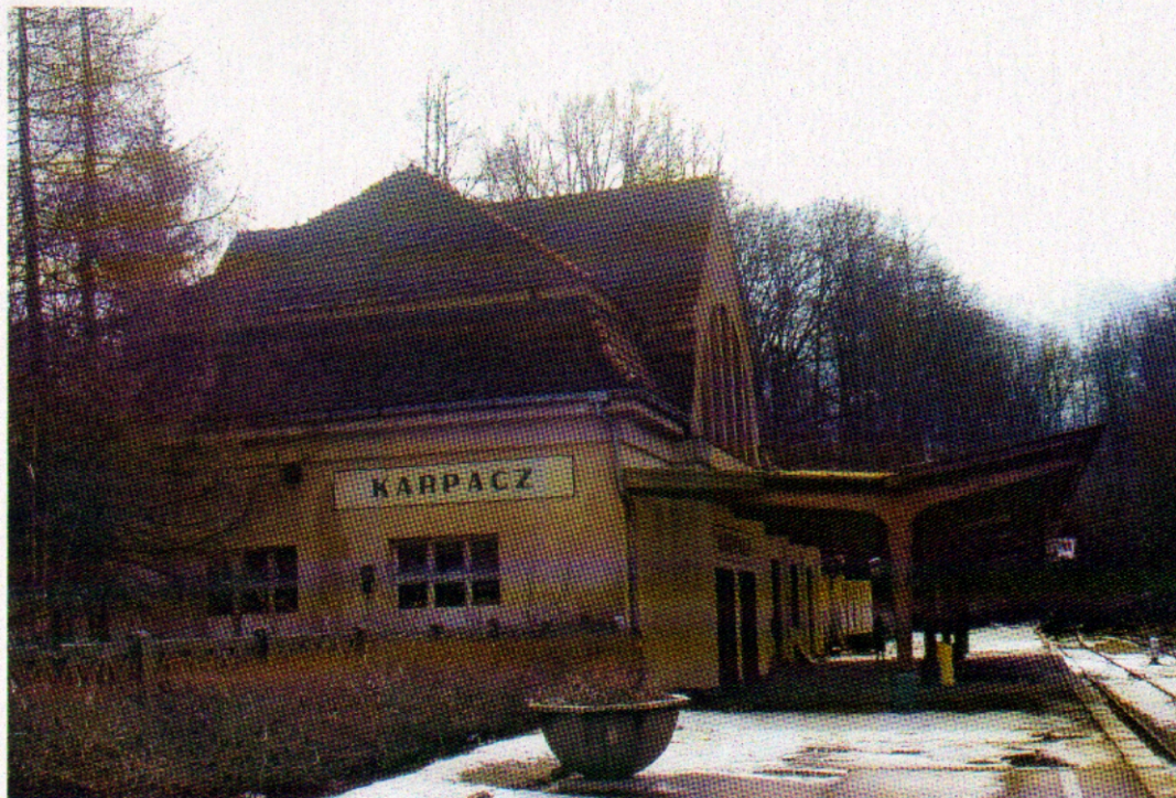
Fot.4 – Widok na peron kolejowy, wiatę i elewację północną dworca kolejowego.
