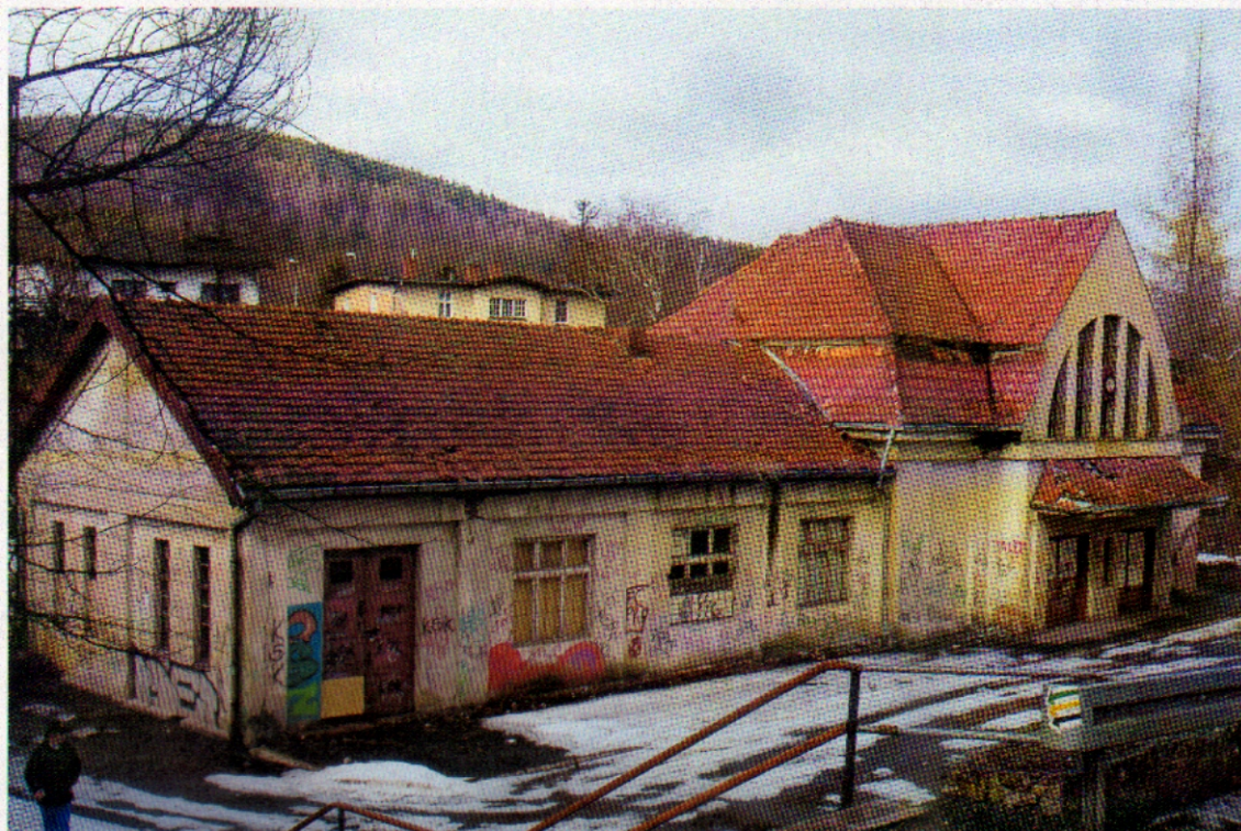
Fot. 1 Budynek dworca kolejowego – widok od strony południowo –wschodniej.
