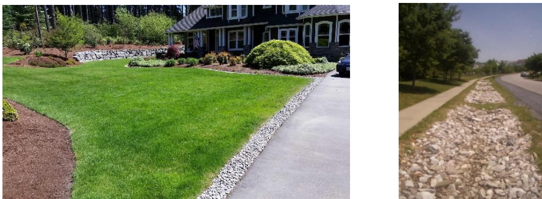
Ryc. 3 Drenaż francuski, źródła (od lewej): https://harborgreenscapes.com/drainage/french-drain/ ; https://sustainablestormwater.org/2007/05/23/infiltration-trenches/
