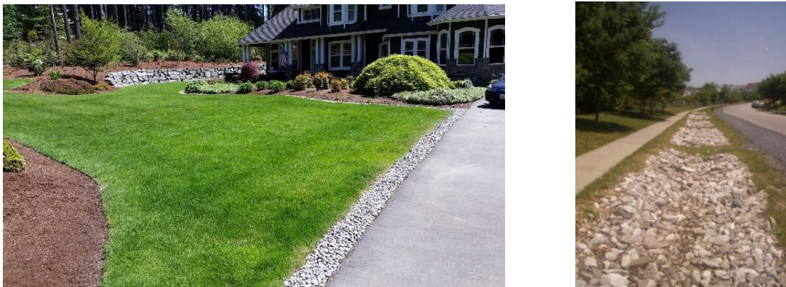
Ryc. 3 Drenaż francuski, źródła (od lewej): https://harborgreenscapes.com/drainage/french-drain/ ; https://sustainablestormwater.org/2007/05/23/infiltration-trenches/
