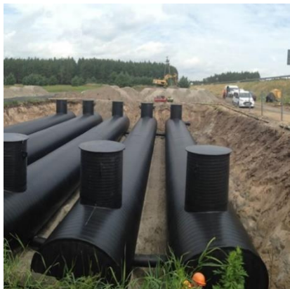
Ryc. 11 Zbiorniki podziemne, źródła (od lewej): https://www.uponor.pl/ ; https://ecol-unicon.com/produkty/produkty-deszczowe/zbiorniki-retencyjne-hydrozone/
