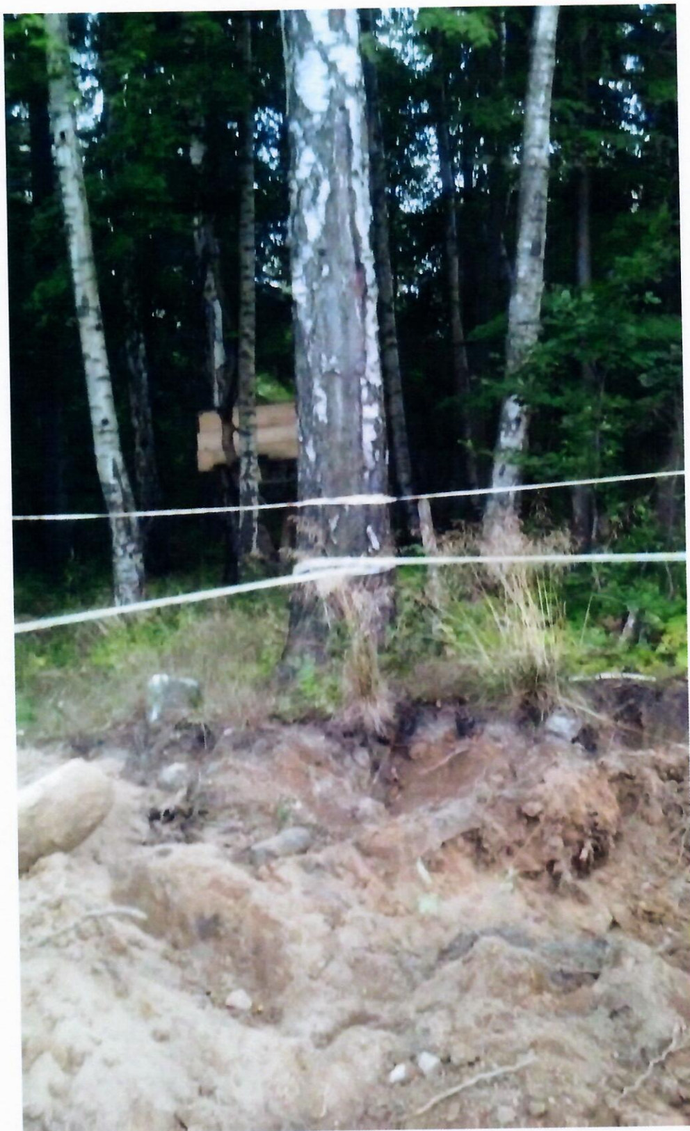
Ulica Słowackiego – prowadzone prace ziemne w obrębie korzeni.
