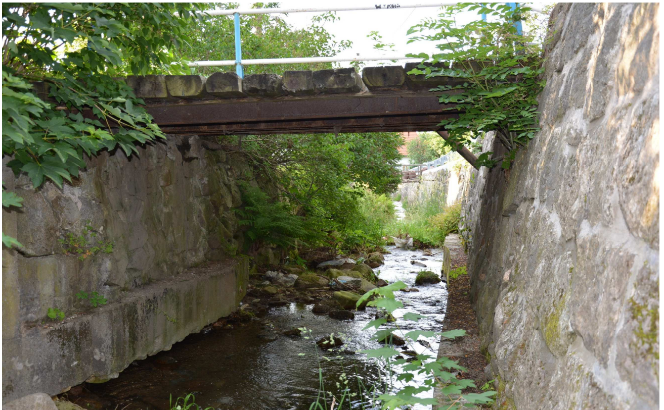
Widok ogólny obiektu mostowego
