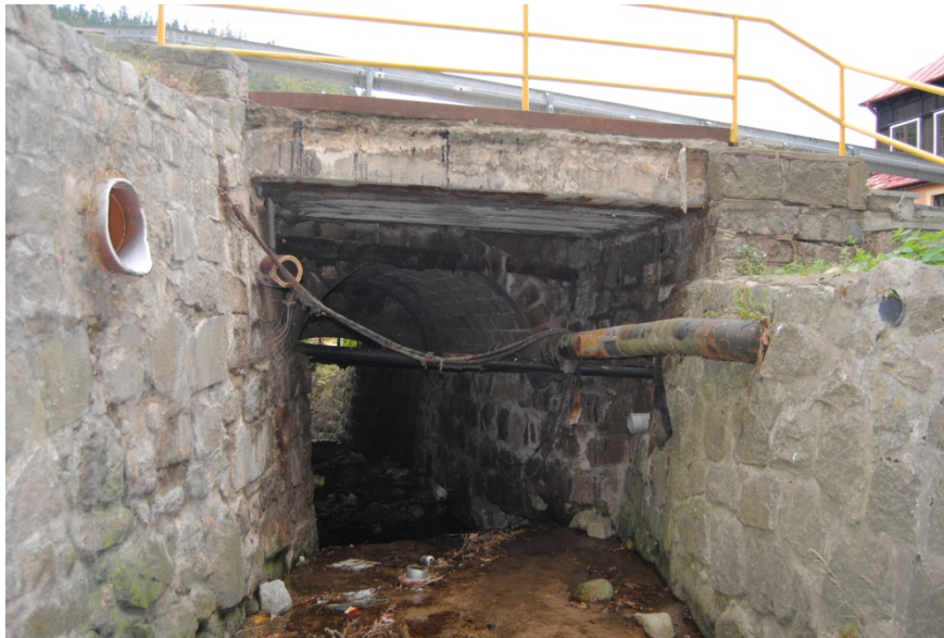
Widok od strony górnej wody
