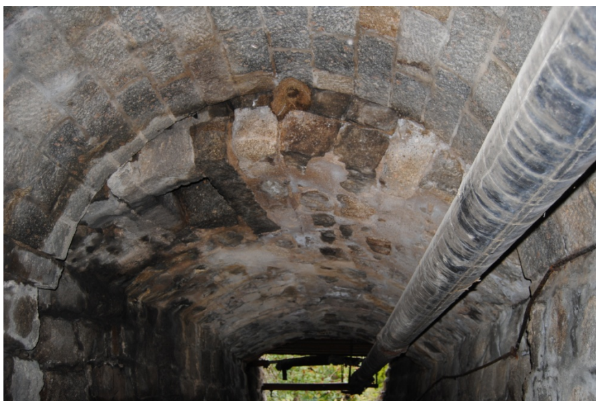
Konstrukcja pod jezdnią ul. 3-go Maja
