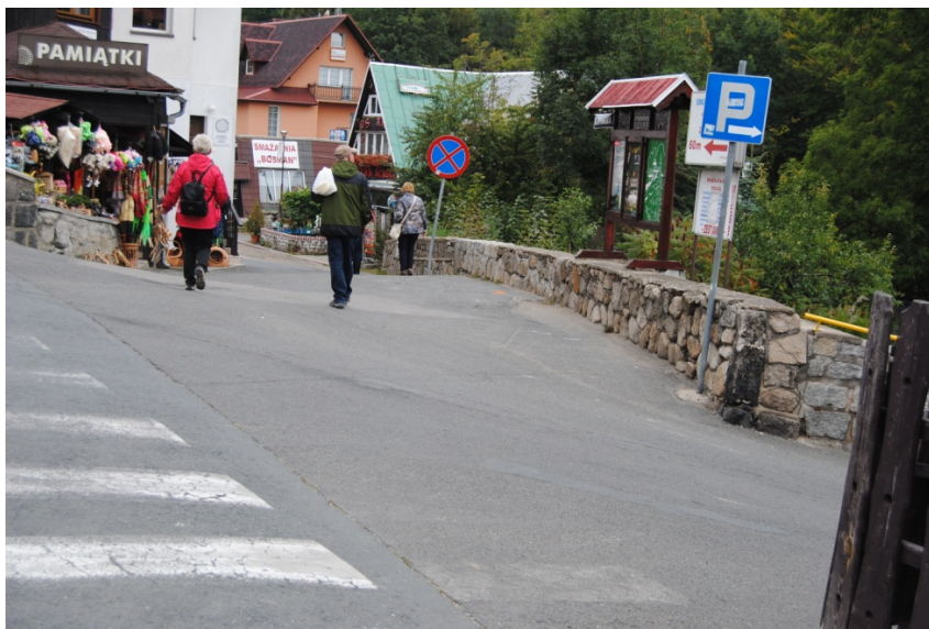
Jezdnia nad obiektem (ul. Rybacka), brak balustrady na murze
