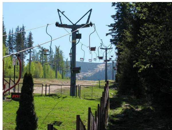
2. Dolny odcinek kolei – widok w kierunku Kopy.
