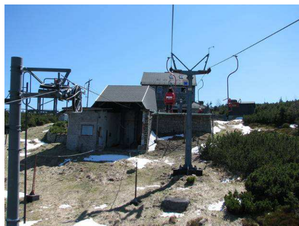
6. Górna stacja kolei.
