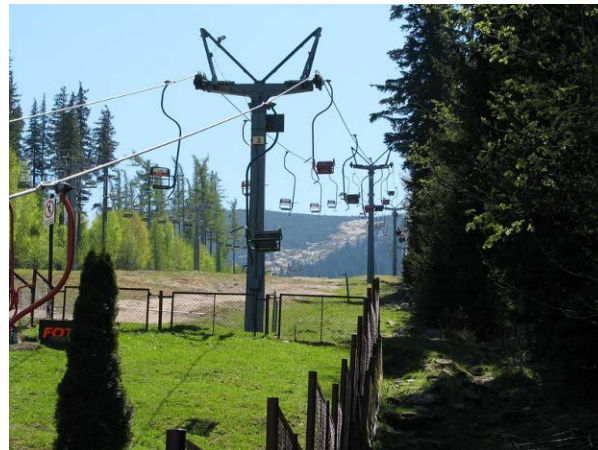
2. Dolny odcinek kolei – widok w kierunku Kopy.
